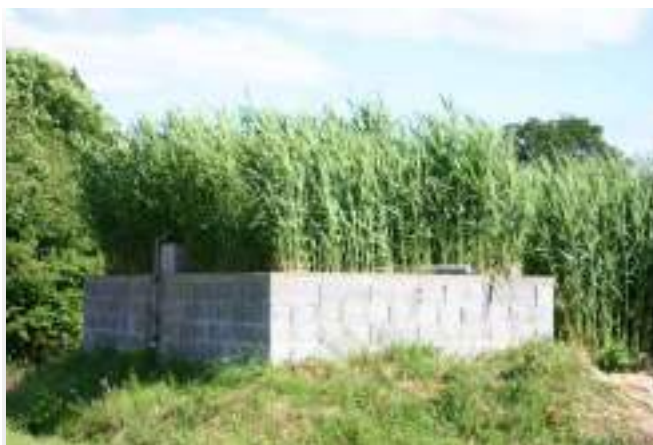
Photo 22 : Le traitement des effluents par les roseaux
