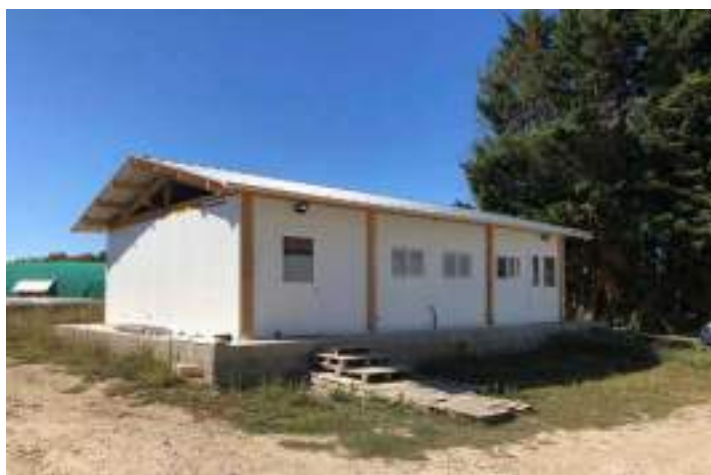
Photo 18 : Fromagerie en panneaux sandwich avant bardage bois
