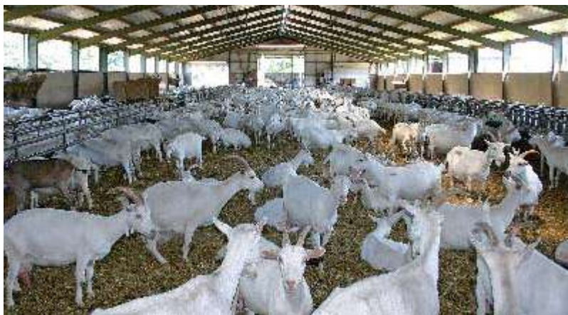
Construire une nouvelle stabulation avec un système de volets d'aération permet d'avoir toute l'année un climat de stabulation idéal.
